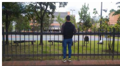
Mejoramiento Cerramiento Perimetral
