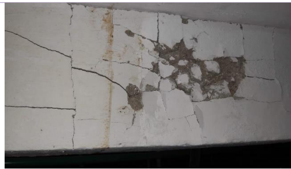
Foto 3. Falla con fracturación total del concreto por esfuerzos internos inadmisibles.
