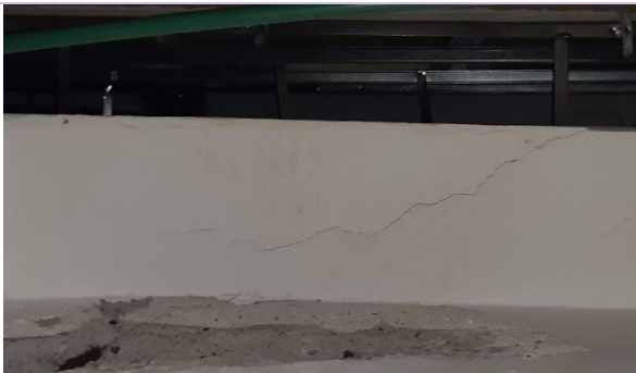
Foto 3. Falla con fracturación total del concreto por esfuerzos internos inadmisibles.
